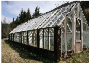
Gróðurhúsið við Fífilbrekku er gott dæmi um það hvernig fyrstu gróðurhúsin voru byggð hér á landi
